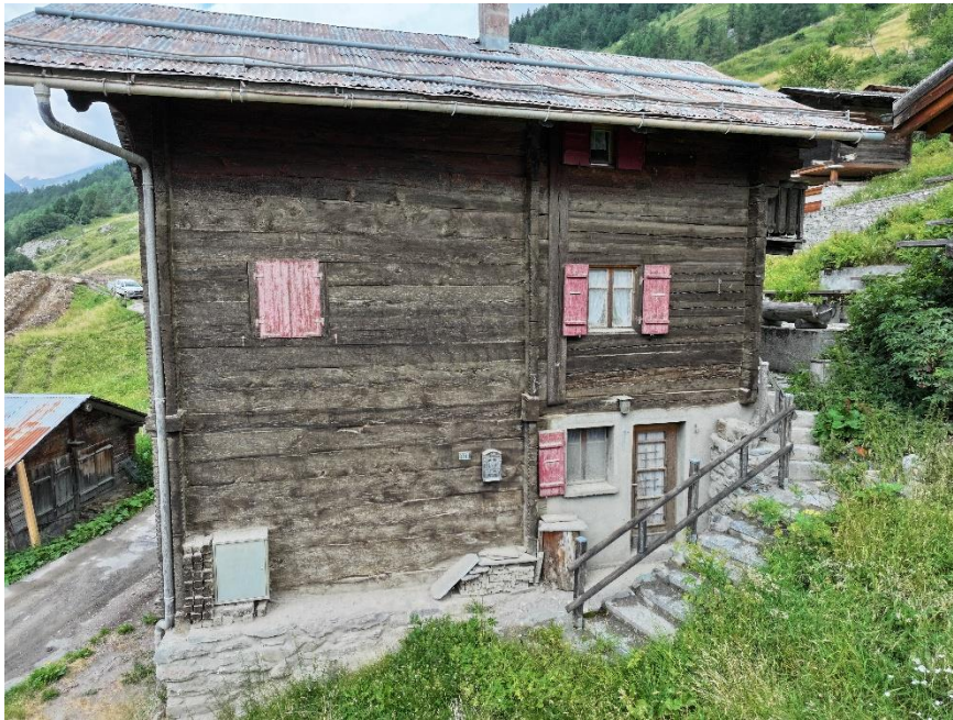
Abb.5 Ansicht einer betroffenen Fassade
