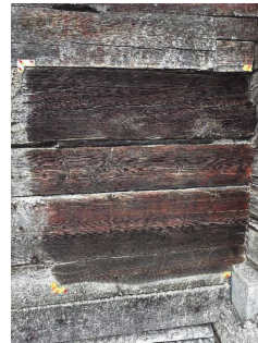
Reinigung der Häuserfassade – Vor- und Endzustand Musterfläche
