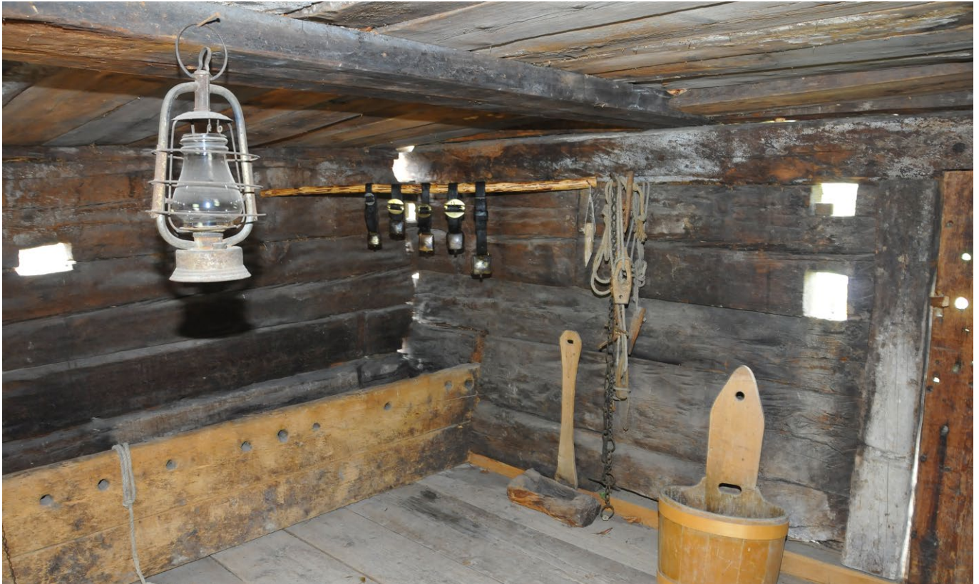
30 Freilichtmuseum der Schweiz, Heustall aus Blatten: Im Inneren des Stalls wurde die fehlende Futterkrippe mit Anbindelöchern aus dem Bestand des Freilichtmuseums rekonstruiert. Aufnahme 2019.
