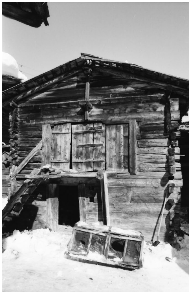
20 Blatten, Heustall Ebener: Die Frontseite des Heustalls. Der Giebelbereich wurde durch eine Blockzange stabilisiert. Aufnahme 1984.
