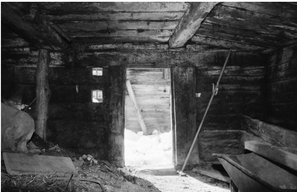
22 Blatten, Heustall Ebener: Das Stallgeschoss. Die Stalldecke war in der Mitte zwischen den Bindern horizontal, rechts und links davon fielen sie wenig gegen unten ab. Blick nach Westen. Aufnahme 1984.
