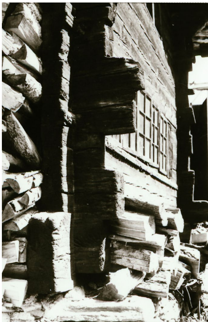
14 Blatten, Haus Ebener: Unregelmässig vorstehende Blockvorstösse an der Südost- und Südwestecke des Stubenblocks, welcher auf der Trockensteinmauer auflag. Aufnahme um 1970.
