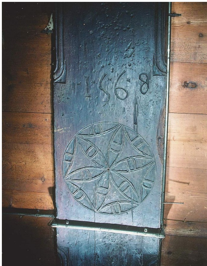
8 Blatten, Haus Ebner: di Binda – der quer zur Firstrichtung, West-Ost laufende Unterzug an der Stubendecke mit Baudatum 1568 und eingekerbter Rosette. Aufnahme 1983.
