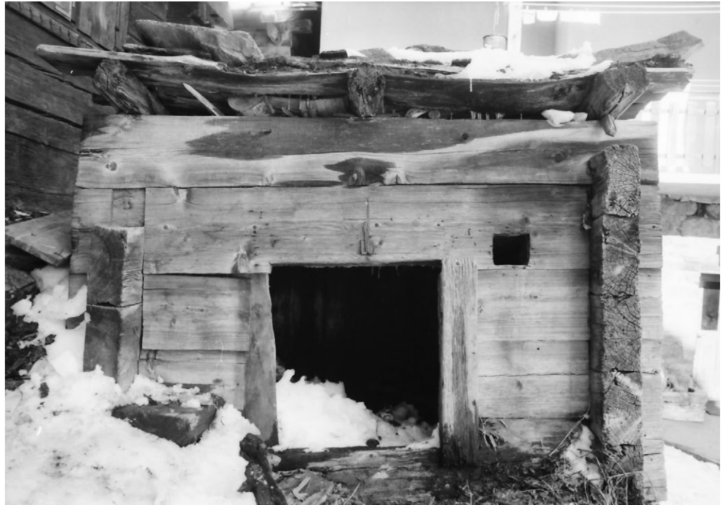
23 Blatten, Schweinestall Ebener: Westansicht des Schweinestalls ohne Türblatt. Links unten ist der Überstand des Schweinetrogs, welcher von aussen eingefüllt wurde, in Ansätzen sichtbar. Aufnahme 1984.
