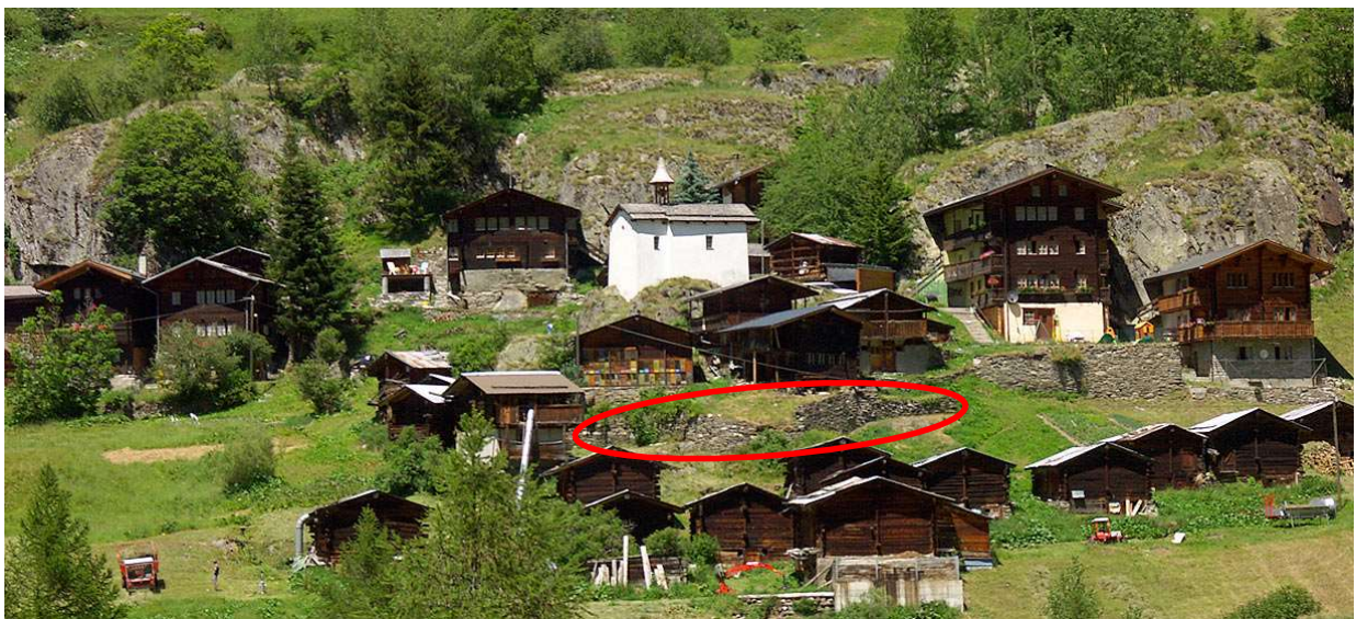
Das Unterdorf von Eisten mit dem sanierungsbedürftigen Teil (rot markiert), in drei Abschnitten Foto Ueli Raz 2006
