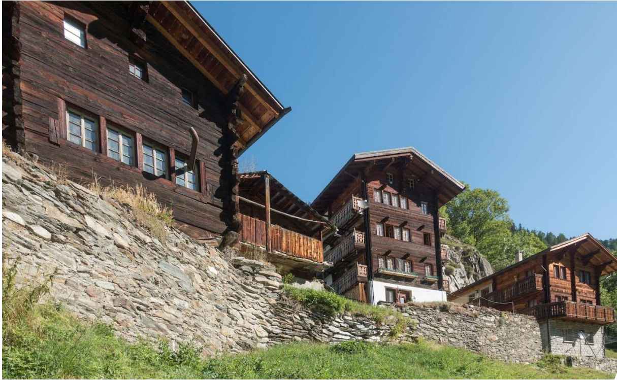
Der mittlere und östliche Mauerteil. Die neueren Stützmauern unter den beiden Wohnhäusern sind nicht Bestandteil der Wiederherstellung
